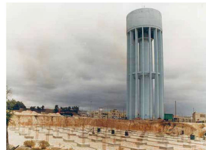
Reservatório elevado da Bela Vista (c. década de 1980) Fonte: Coleção de António Pinho.
