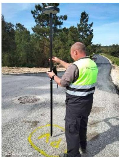
Figura 16 – Levantamento de Cadastro GPS
